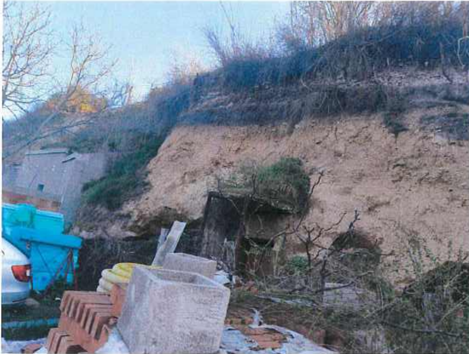
3.kép: a töredezett, mállott törmelékes partfalon lógó gyökerű cserjék és kilazult közettömbök maradtak, melyek folyamatosan peregnek. A háttérben látható a szomszédos hasonló omlást stabilizáló szerkezet. Ugyanilyen megtámasztás szükséges ezen a szakaszon is. A sziklafal tövében és az előtető felületén láthatóak a friss omlások kúpjai.
