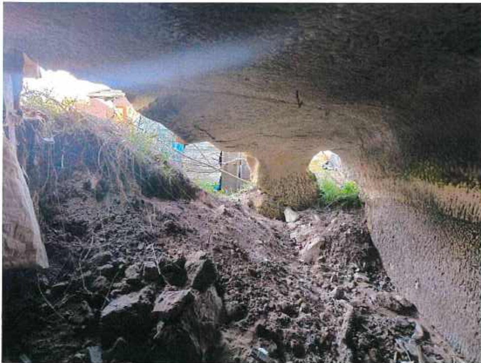
4.kép: Az omlás beszakította és részlegesen elzárta a középső bejárható pince vékony köztömbökkel határolt lejárátát. A töredezett bejárati rész elterelése után a pince lejárata csatlakozhat a megépülő támfalhoz.
